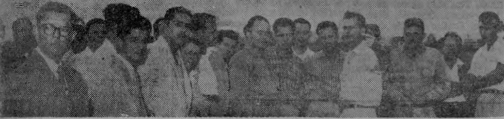
En la foto superior puede apreciarse la motoniveladora "Caterpillar", cuando efectuaba el corte de tipo "V". En ochenta minutos, lo que se considera un récord, realizó esta motoniveladora un trecho completo, propio para camino vecinal, de cien metros de longitud. En la gráfica inferior se observa parte de los asistentes a la demostración de ayer, cuando los funcionarios de "Matra Ltda.", explicaban las características de la motoniveladora "Caterpillar", modelo 12.
